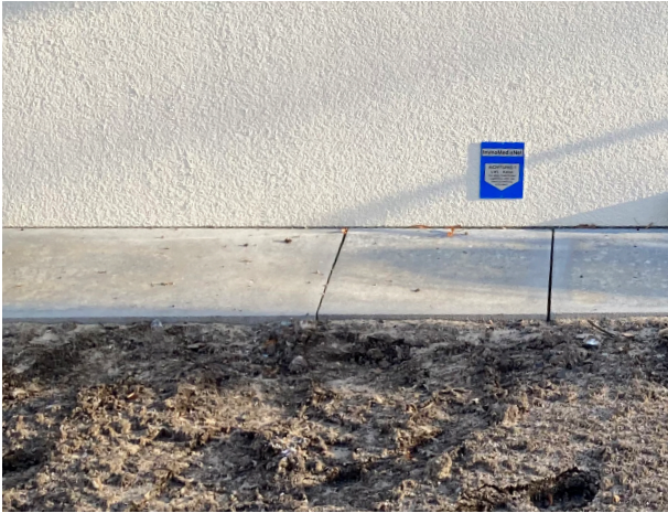
Taufstreifen Breite 30cm Betonsteinplatten: 60x30 cm
