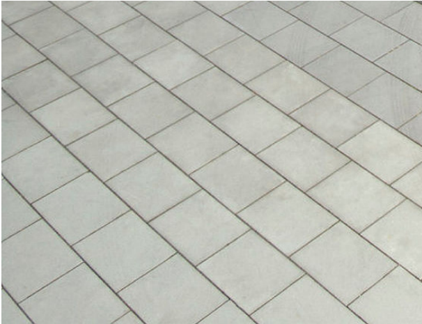
Pflaster Platz und Wege, Farbe hellgrau, sickerfähig, Abflussbeiwert \psi = 0,25 Format: 30x20cm
